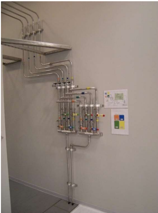
回収ライン マニフォールド 着色により直感的な操作を可能にしています。
