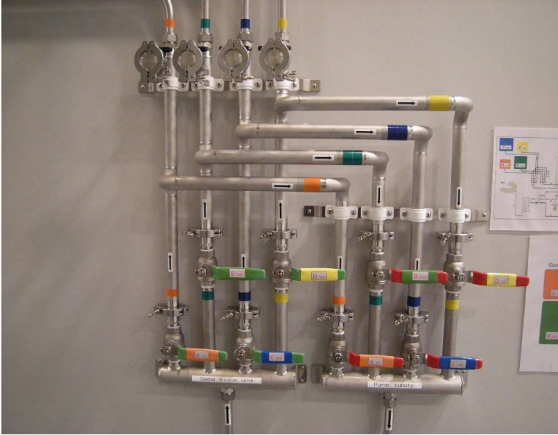
回収ライン マニフォールド 着色により直感的な操作を可能にしています。
